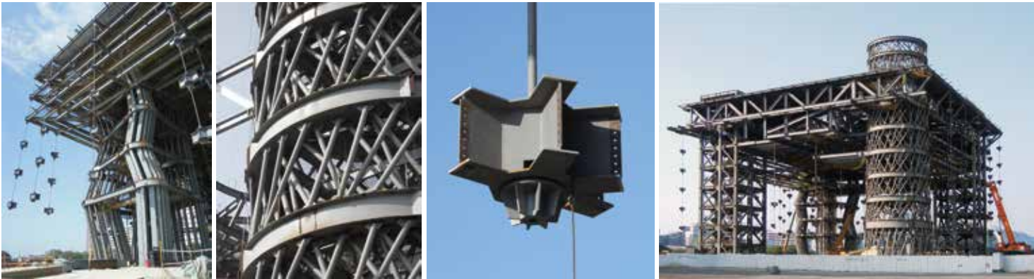
懸吊式鋼棒支撐各層樓版結構
