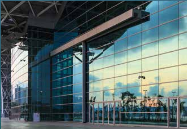
高12米、寬12米電動玻璃大門以利大型機具駛入館內
