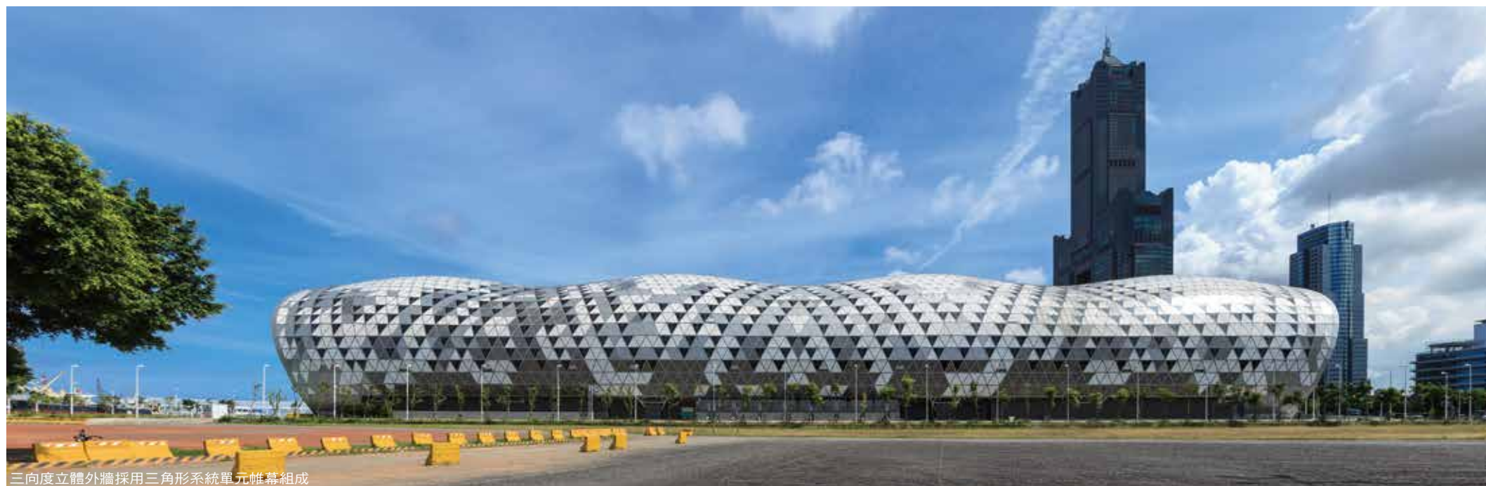
三向度立體外牆採用三角形系統單元帷幕組成
